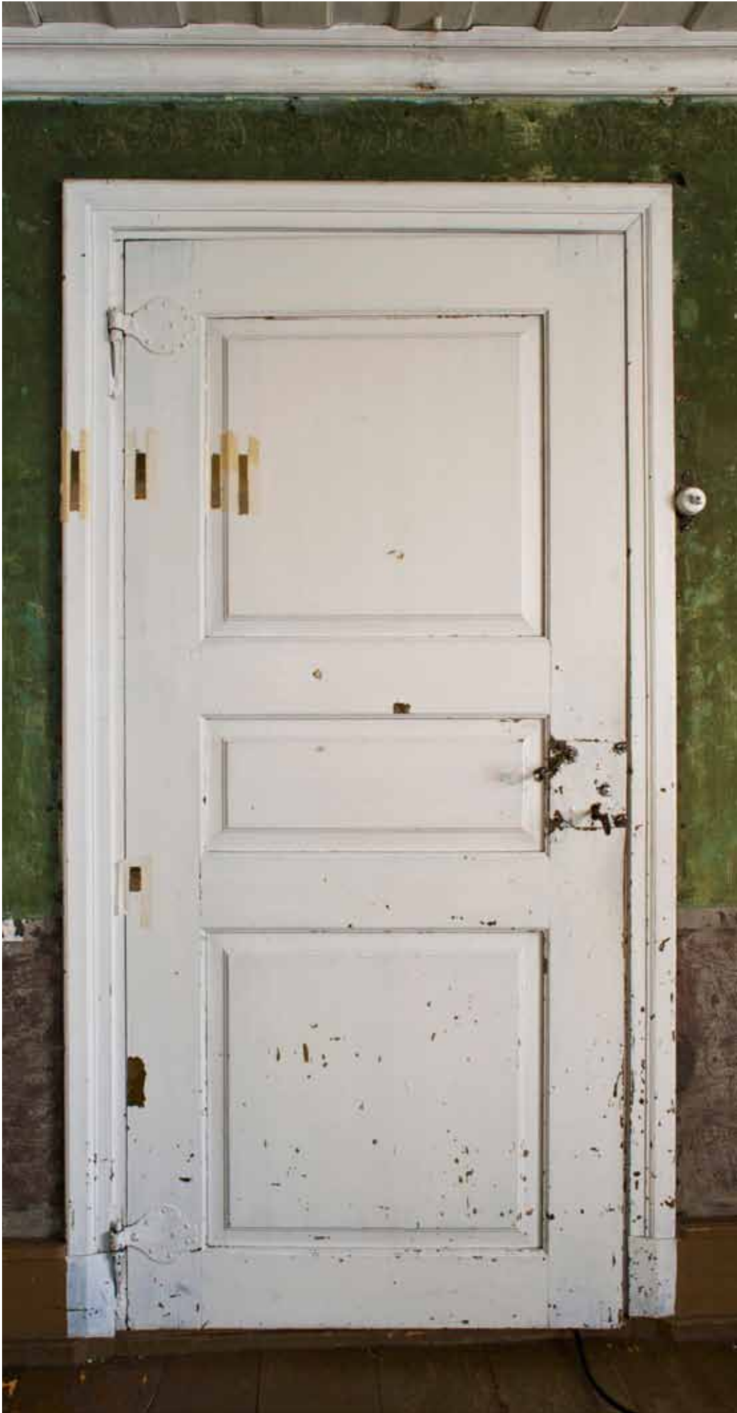
Salsdøren på østveggen.
