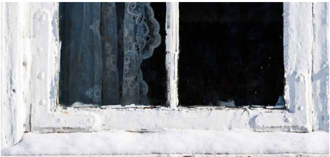
Under: Nærfoto viser beslag. Hjørnejern med avrundede avslutninger.
