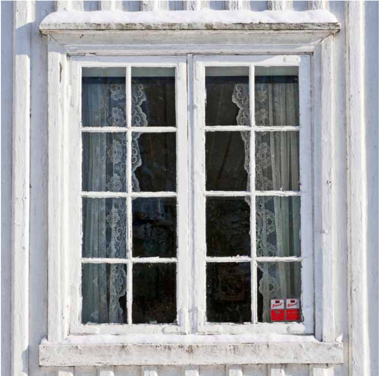
Over: Vindu i første etasje på gavlveggen mot vest. Opprinnelig vindu og omramming.
