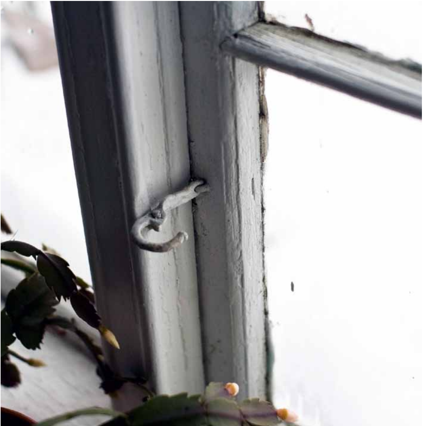
Haspe østre vindu sydvegg. Haspen er en relativt uvanlig type som representerer et mellomledd mellom de gamle fuglehodehaspene og de støpte haspene med fingerkrok fra tiden etter midten av århundret. Legg merke til antydningen til fuglehodeprofil og knoppen som avslutter fingerkroken.
